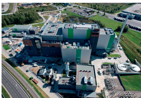
Instalacja termicznego przekształcania odpadów w Olsztynie
