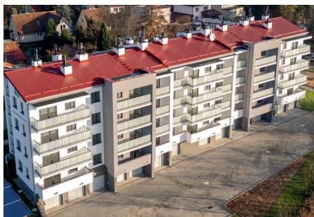
Trzy budynki wielorodzinne z wbudowanymi w bryłę garażami indywidualnymi przy ul. Truskawkowej 8, 10, 12 w Olsztynie – pierwsza w mieście inwestycja objęta rządowym programem „Mieszkanie na start”, oferująca najmcom możliwość bezzwrotnych comiesięcznych dopłat do czynszu przez 15 lat. W ramach przedsięwzięcia wybudowano 44 mieszkania wykończone „pod klucz”, przeznaczone na wynajem
