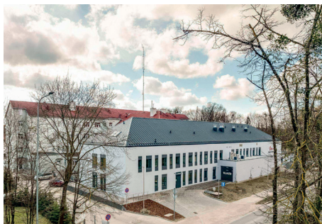
Rozbudowany Szpital w Ostródzie na potrzeby Izby Przyjęć, Zespołu Pracowni oraz Oddziału Chirurgii Urazowo-Ortopedycznej
