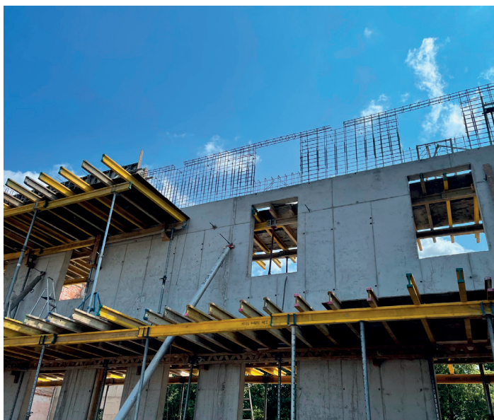
Budowa ściany żelbetowej
