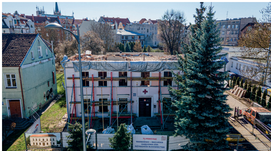
W samym centrum Olsztyna, przy ul. Partyzantów 82, od 20 stycznia 2025 r. trwa przebudowa obiektu – nowej siedziby Warmińsko-Mazurskiej OIIB. Za roboty budowlane odpowiedzialna jest firma Dachland z Olsztyna.
