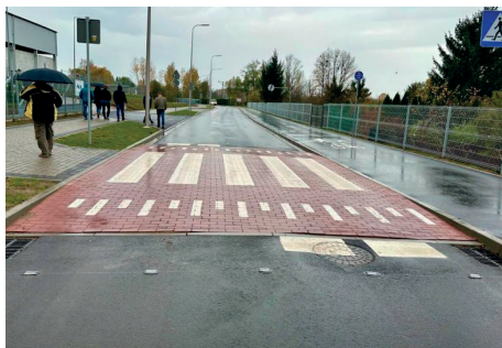
Rozbudowa z przebudową drogi gminnej: ul. Rataja w Nidzicy. Oprócz nowych chodników, parkingów i nawierzchni na odcinku od ul. Traugutta do Kraszewskiego powstała również ścieżka pieszo-rowerowa, pasy zieleni i oświetlenie uliczne z oprawami LED, nowe nasadzenia i bezpieczne przejścia dla pieszych
