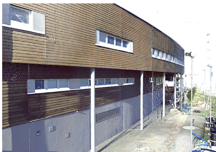
Rys. 1. Chmura punktów bryły budynku lecznicy wykonana w celu kontroli bezpieczeństwa prac budowlanych, dla istniejących obiektów szpitalnych
