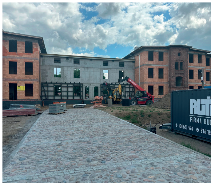
Montaż konstrukcji szachulcowych na ścianach żelbetowych
