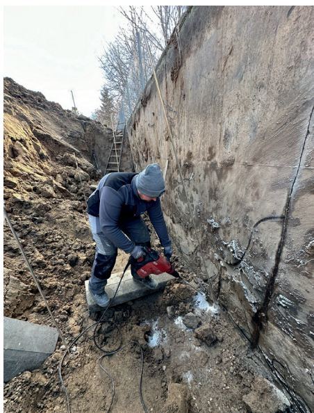
Zakładanie lanc do iniekcji na tle spękanej ścianie oporowej od wewnątrz
