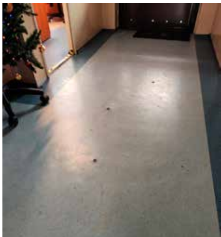
Po podniesieniu posadzki zostały tylko ślady po otworach do aplikacji injektu
